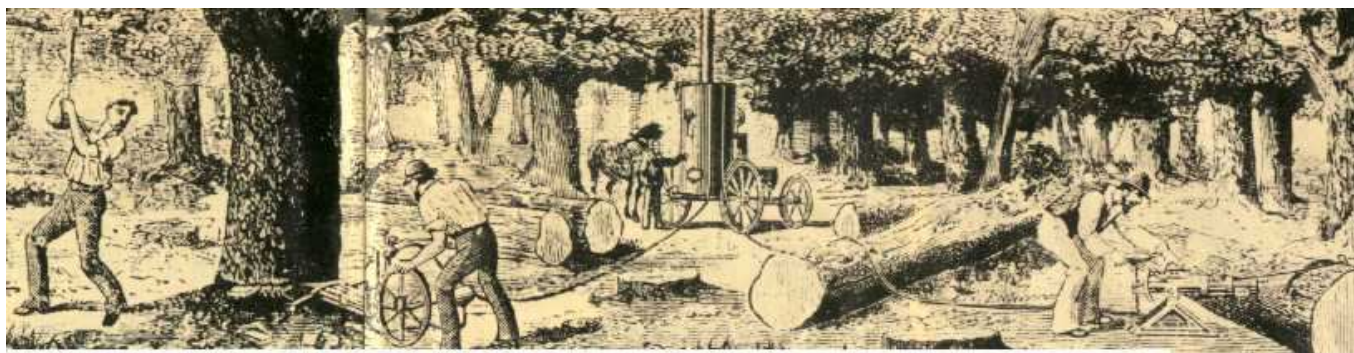
doc. Scies à Moteur N°100 1986. Scies alternative à pistons fonctionnant avec la vapeur, invention d'un anglais A. Ransome vers 1860 !
